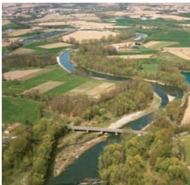
Vista aerea del fiume Oglio a Pumenengo (Bg): in basso a destra la traversa del cavo Molinara
