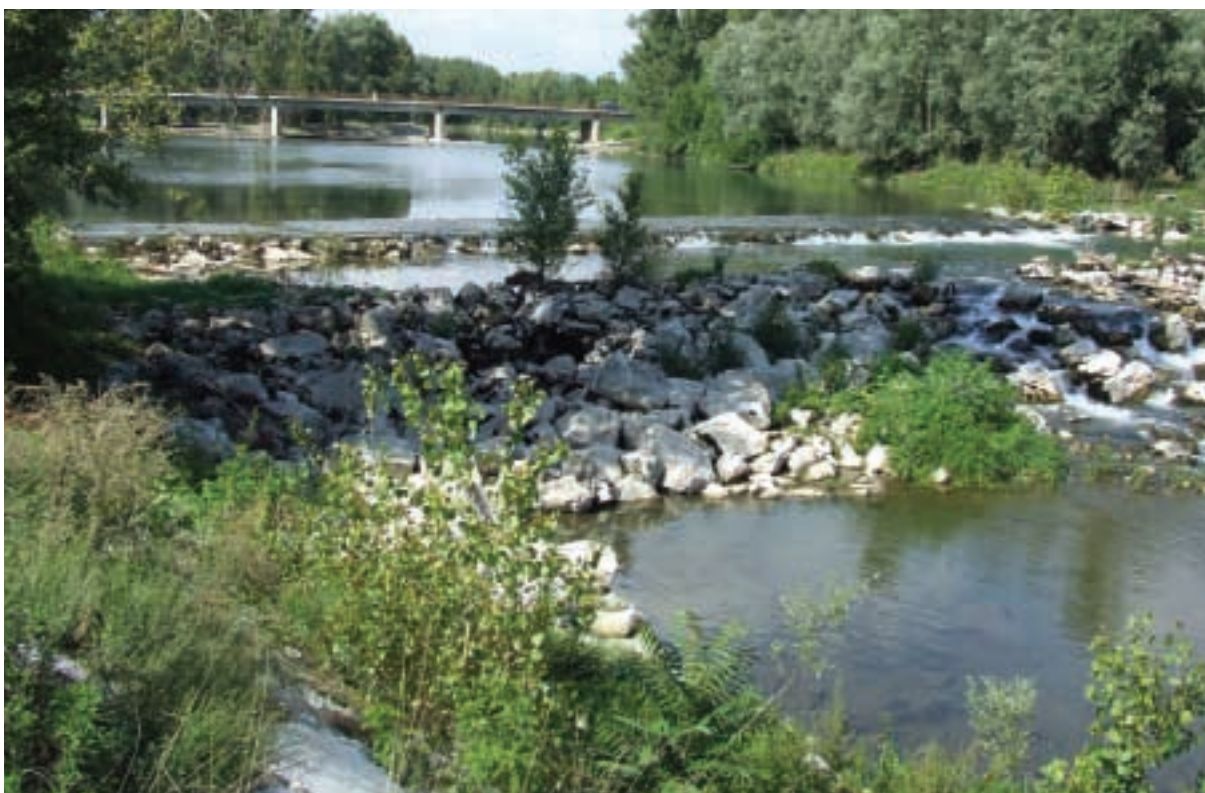
Il fiume Oglio, all'altezza del Traversa del cavo Molinara, in Pumenengo (Bg), come appariva ai primi giorni di agosto del 2007 in piena Stagione Irrigua. La portata transitante era poco superiore a 1,5 m 3 /s.
